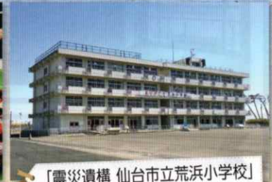
「震災遺構 仙台市立荒浜小学校」
